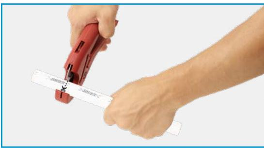
**PASO 1** Cuando corte el tubo de PEX SharkBite, asegúrese de cortar los extremos a escuadra y que la superficie sea regular. Asegúrese de que el accesorio y el tubo de EvoPEX estén limpios y libres de tierra y residuos para realizar la conexión.
