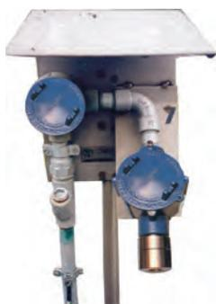
Tejado para protección en intemperie en acero inoxidable para 1 detector EExd, montaje en pared.
