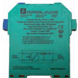
Aislador galvánico. Permite conectar hasta 2 sirenas convencionales de seguridad intrínseca BANI-G-24 EEx ia. El aislador galvánico se debe montar en una zona segura fuera del área de riesgo.
