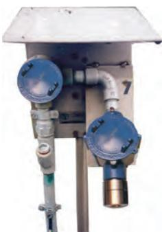
Tejado para protección en intemperie en acero inoxidable para 1 detector EExd, montaje en suelo.
